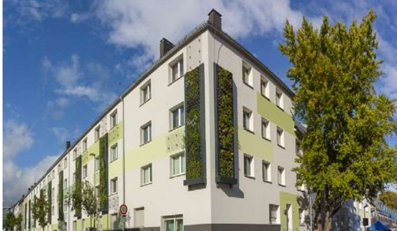
Abbildung 43: Beispiel einer begrünten Fassade.
