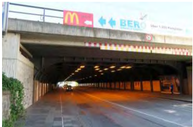
Abbildung 58: Unterführung Buschhausener Straße
