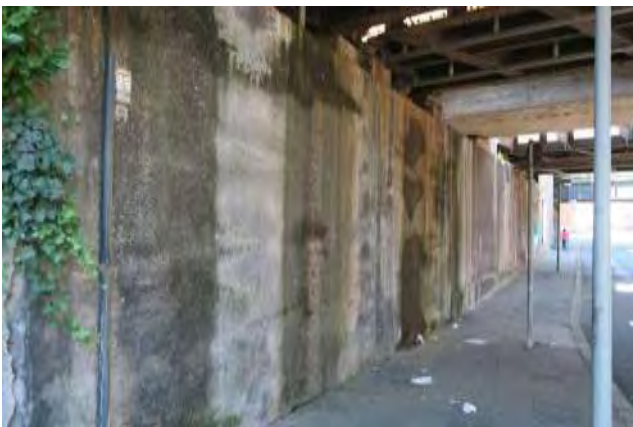
Abbildung 59: Unterführung Marktstraße/ Alleestraße
